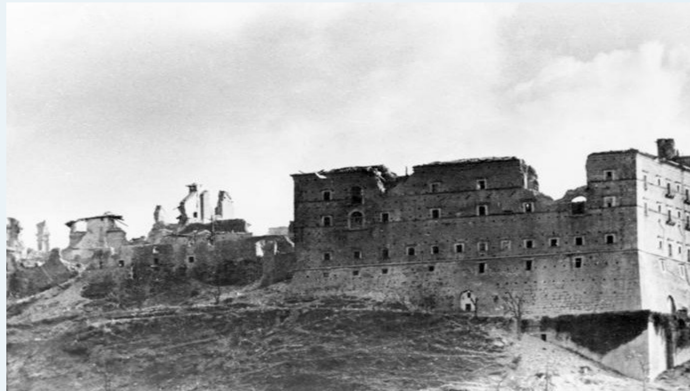
L'abbazia di Montecassino ridotta in macerie dopo il bombardamento del 15 febbraio 1944.
